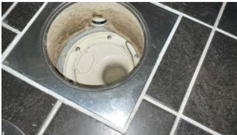
sluk, membran og tettesjikt
