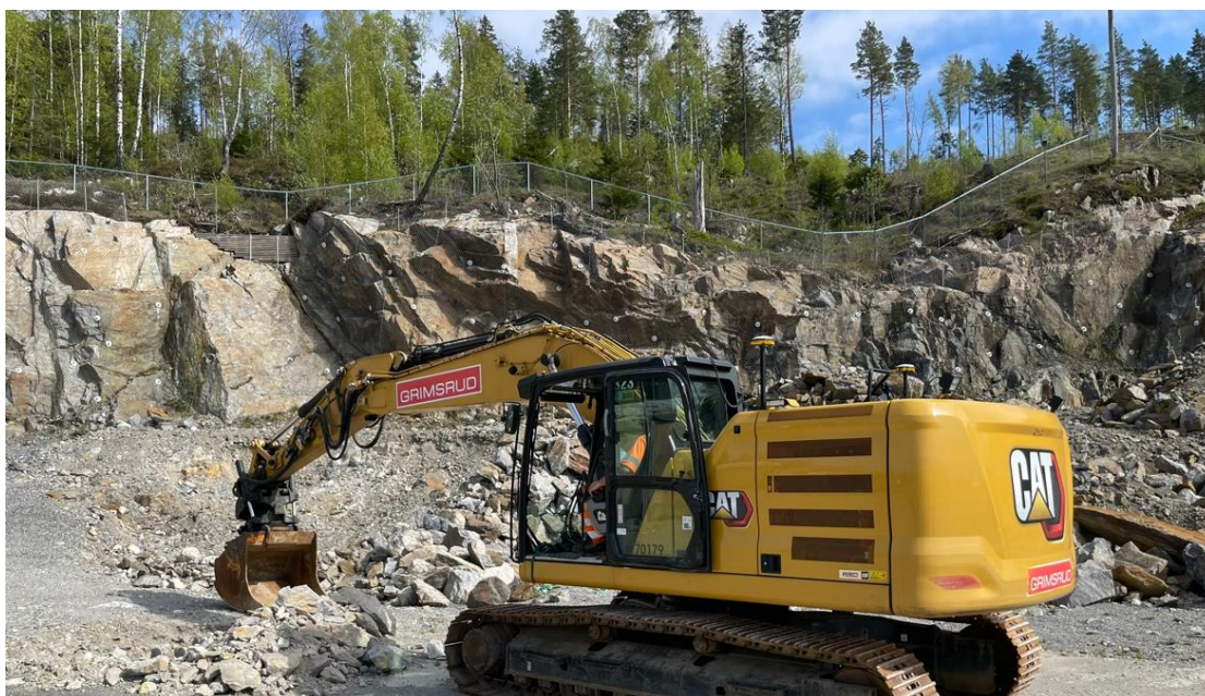
Foto fra byggeplass i dag.
