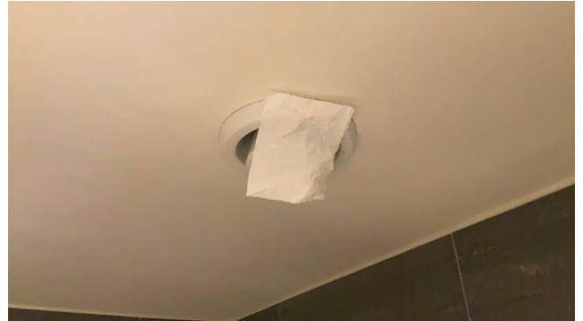
Test av avtrekk. Papiret henger.
