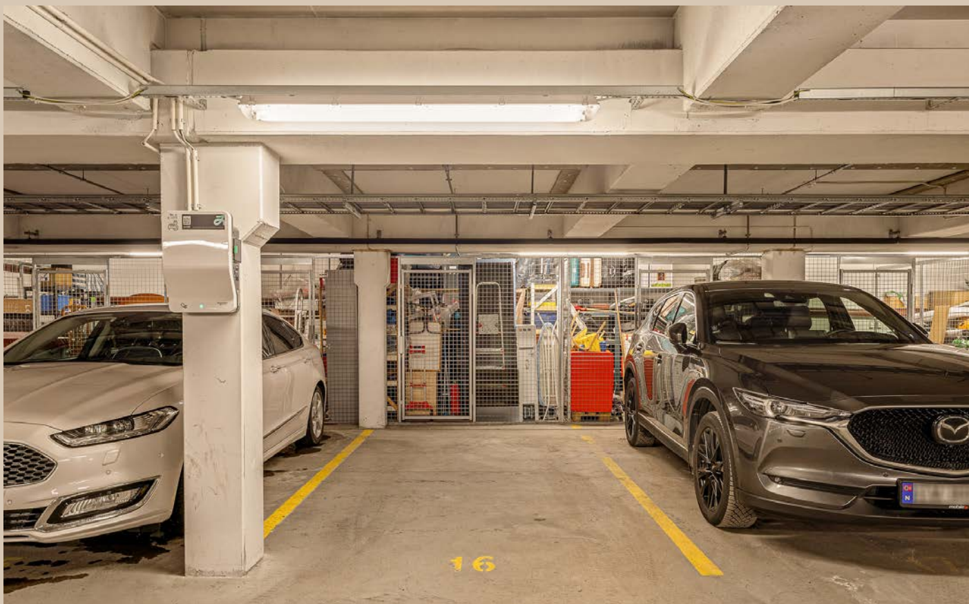
Parkeringsplass med elbil-lader. Sportsbod.
