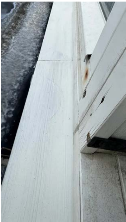
Eksempelbilde av værslitasje/ malingsavflass.
