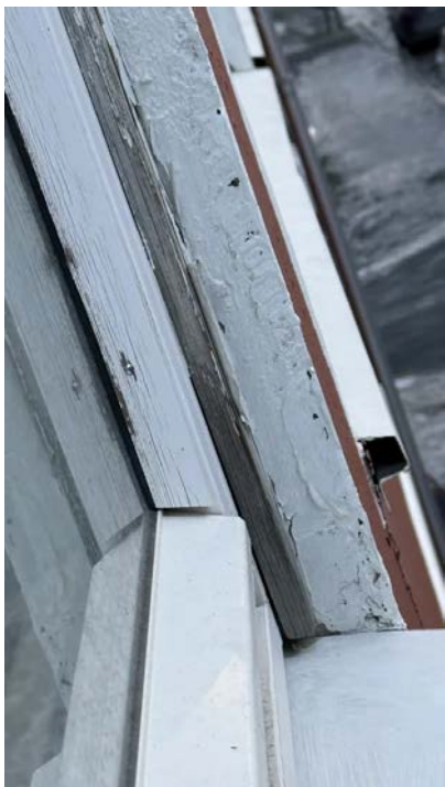
Eksempelbilde av værslitasje/ malingsavflass.
