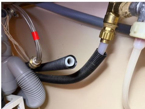
Det mangler pakning/muffe mellom innvendig – utvendig rør i rør i kjøkkenskap.
