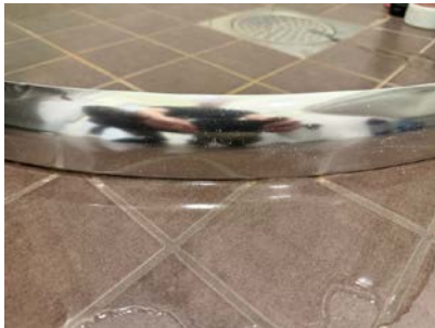
Det er oppkant på dusjhjørne, men det er drenshull i underkant slik at ev. lekkasjevann utenfor dusjsone vil ledes til sluk.
