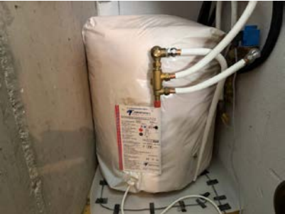
Varmtvannstank i kjøtt.
