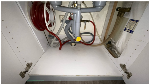
Besiktigelse av røropplegg.
