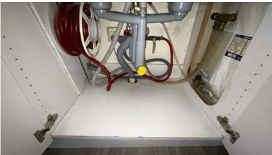
Besiktigelse av rørapplegg.
