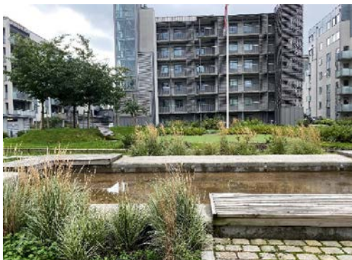
Gårdsrommet bidrar til å fordrøye overvann
