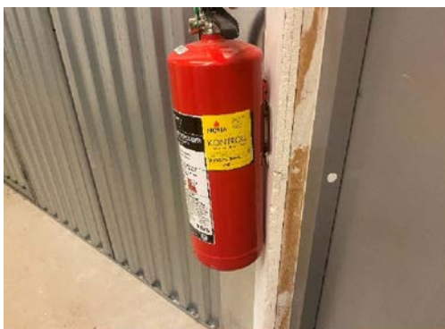
Pulverapparat med avtale om periodisk kontroll
