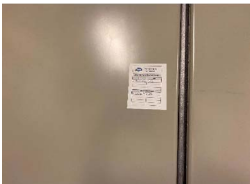
Elektrisk anlegg må kontrolleres regelmessig
