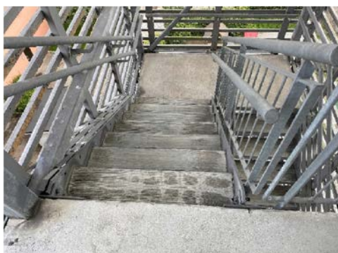
Betong i inntrinn
