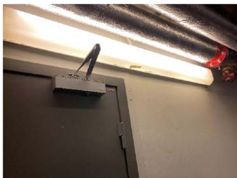
Belysningsarmatur i kjeller
