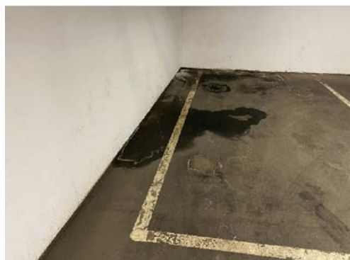
Overflater i parkeringskjeller
