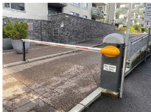
Innkjøring er regulert med bom
