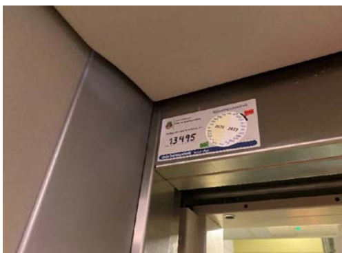
Kontrollmerke. Sikkerhetskontroll utføres annet hvert år
