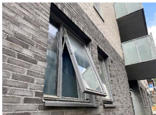
Vinduer med toppsvingmekanisme
