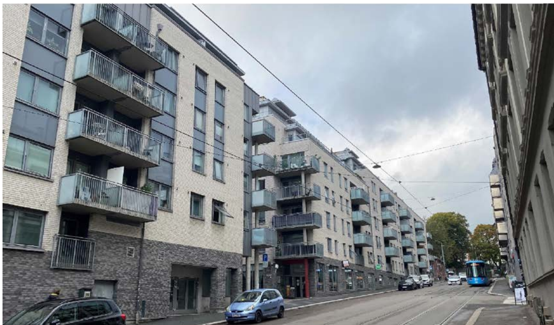
Stor vannføring i Tofte gate ved sterk nedbør kan føre til vanninntrengning
