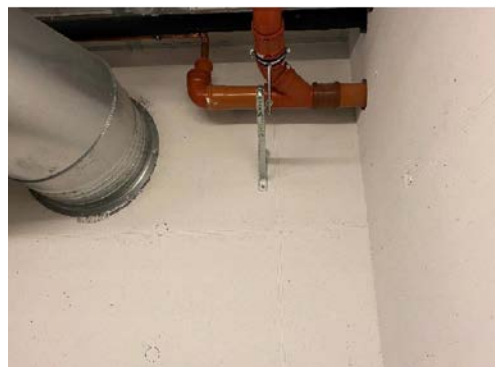
Lett tilgjengelige avløpsrør i kjeller
