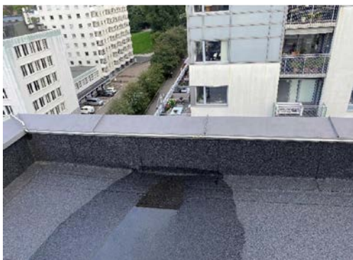
Gassrørledning langs parapet
