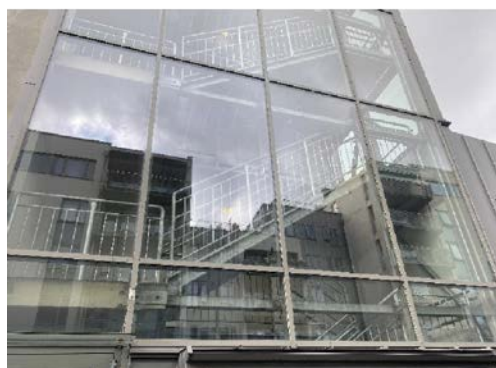
Trapper i materialer av galvanisert stål
