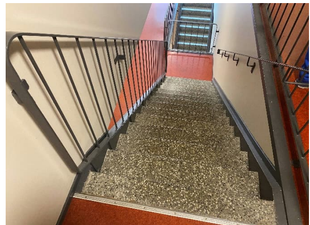
Terrazzo. Håndløper og rekkverk i stål
