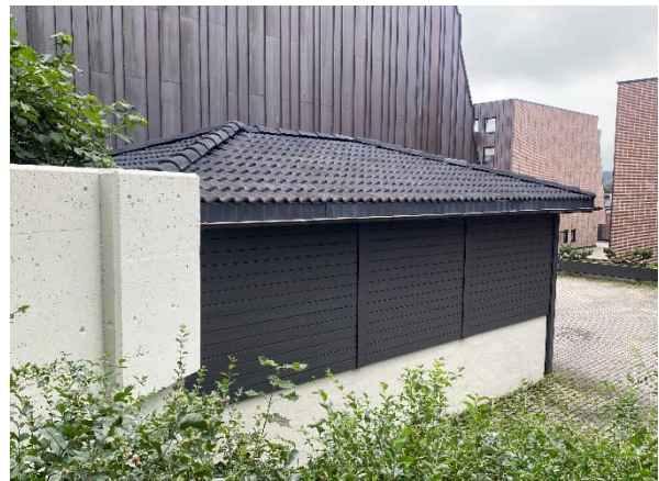
Frittstående vaktmester garasje
