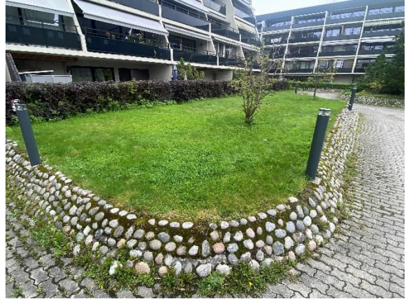
Enkle støttemurer til hager og bed
