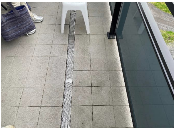
Slukrist og fliser på balkong
