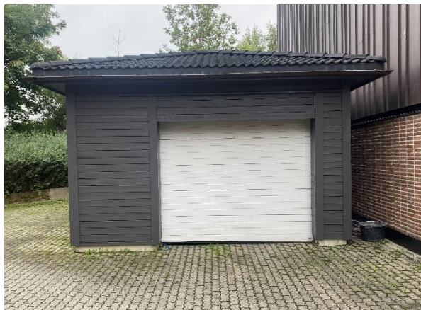
Frittstående nyere vaktmestergarasje
