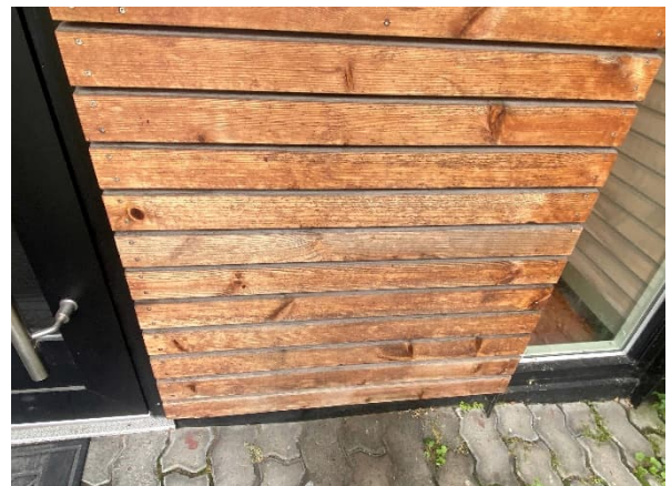
Luftet trekledning v/inngangsparti
