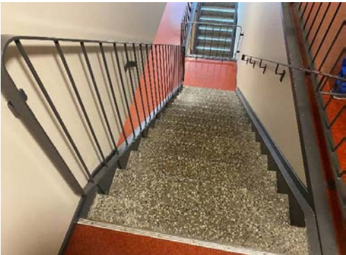
Terrazzo. Håndløper og rekkverk i stål
