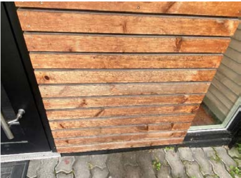
Luftet trekledning v/inngangsparti
