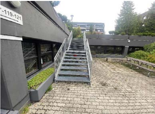
Utvendig strekkmall trapp i galvanisert stål
