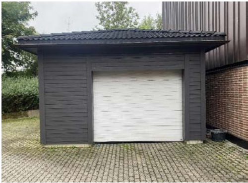
Frittstående nyere vaktmestergarasje
