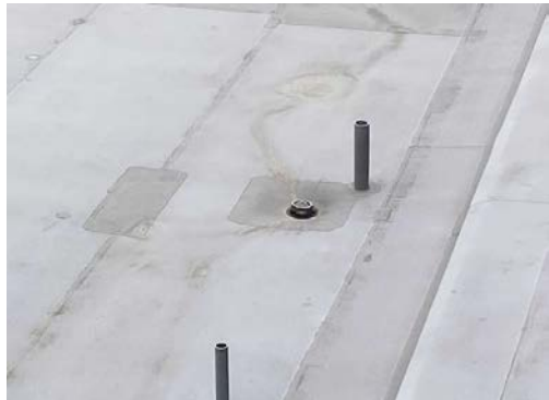
Hovedtak med avrenning til innvendig sluk
