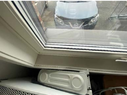
Innvendig. 3 lags isolerglass
