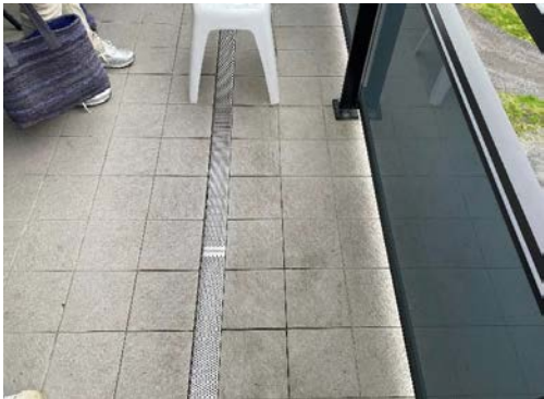
Slukrist og fliser på balkong
