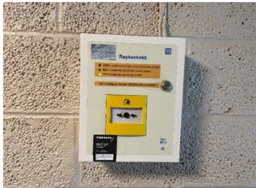
Utløser røykventilasjon
