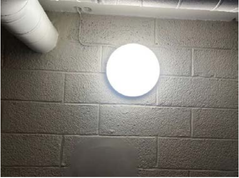
Innvendig belysning på led og sensor
