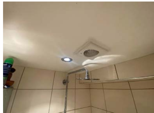
Ettermontert mekanisk avtrekk på bad
