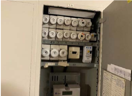
Underfordeling med skrusikringer
