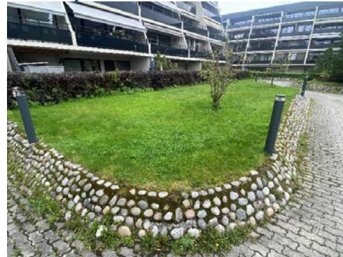
Enkle støttemurer til hager og bed
