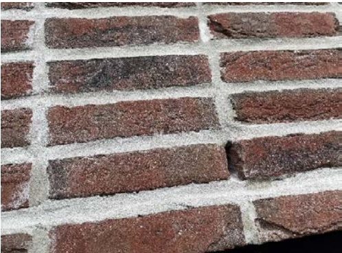
Tegl og stussfuge
