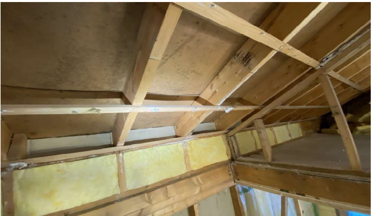
Bilde 34: Viser undertak over trapperom.
