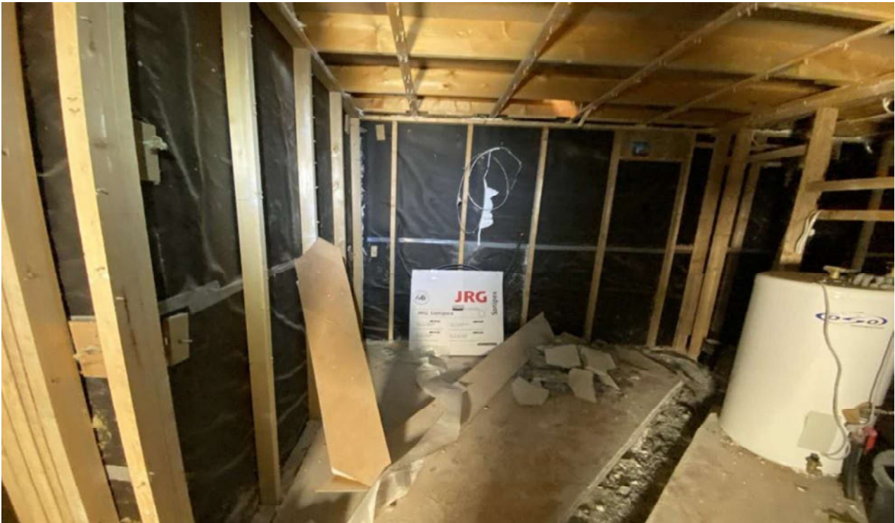
Bilde 3: Viser oversiktsbilde av underetasjen i den delen som tilhører boligen, slik den fremstod ved befaringen.
