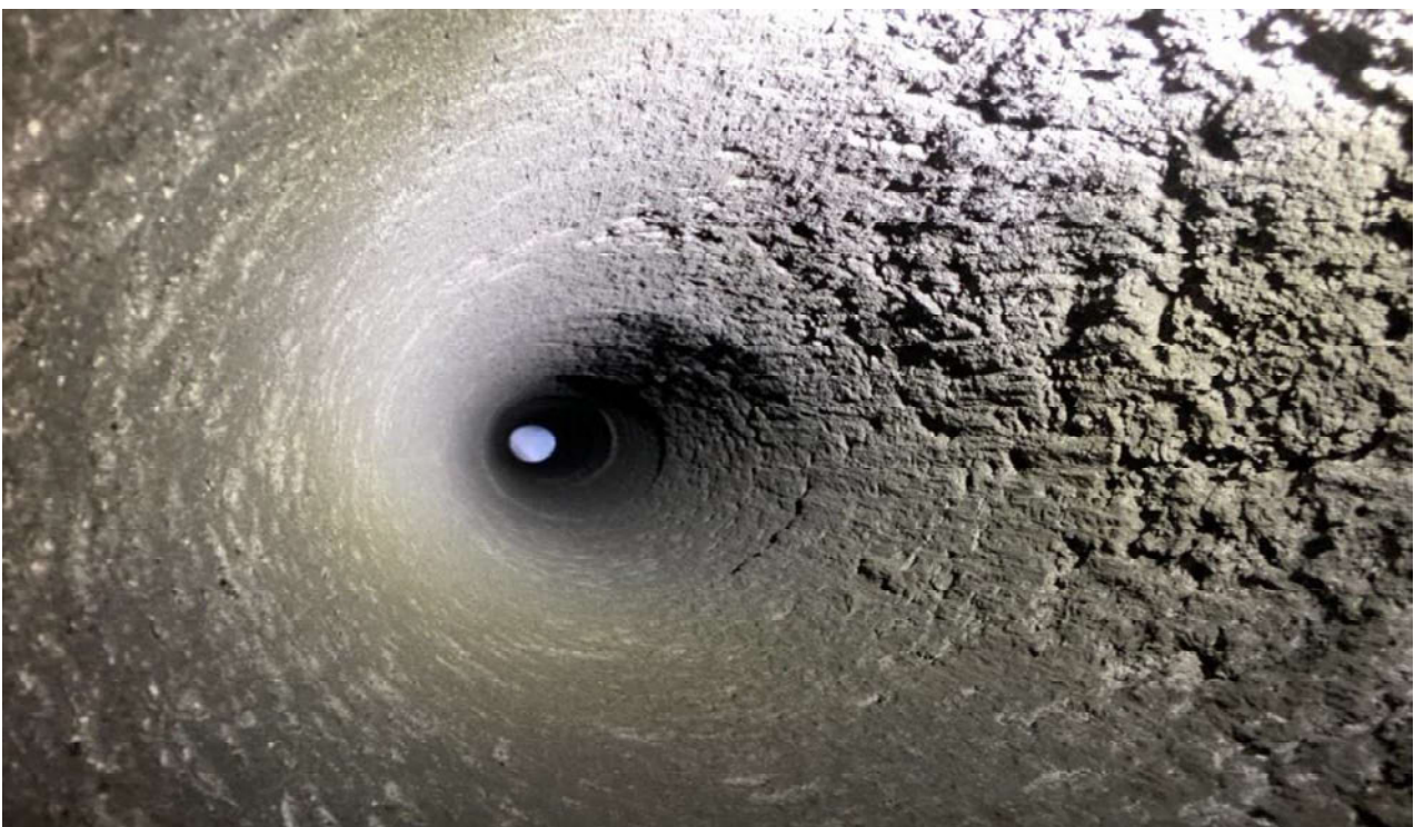
Bilde 43: Viser bilde tatt inne i pipens foringsrør.
