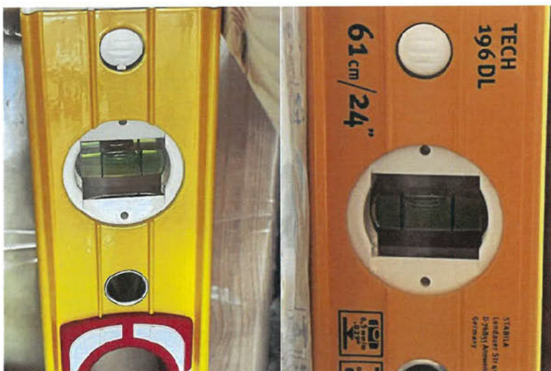
Yttervegg, enkel kontroll av lodd, ved målepunkt 1 og 2
