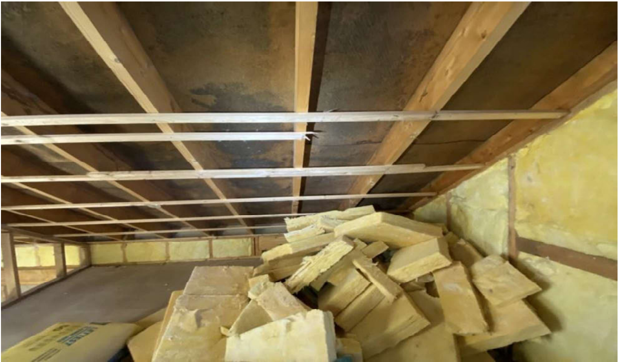
Bilde 35: Viser undertak på loft.
