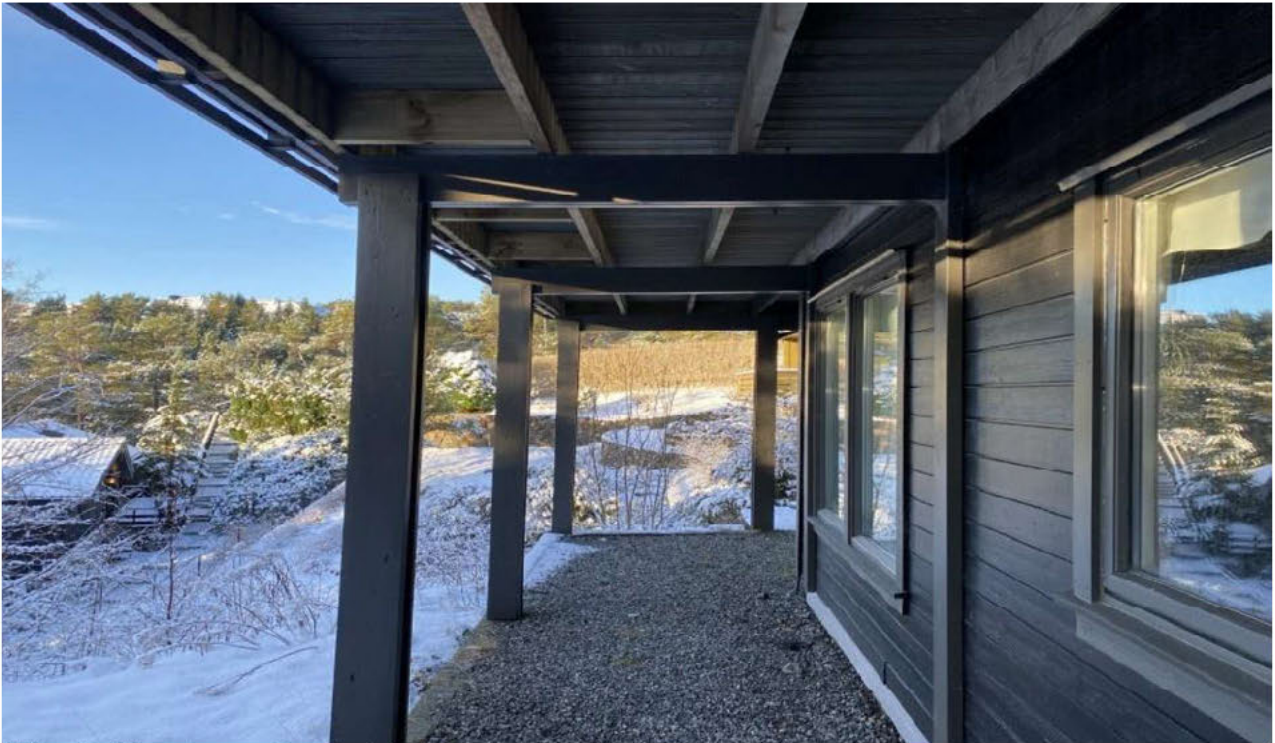
Bilde 15: Viser terrassekonstruksjon sørvest for boligen.
