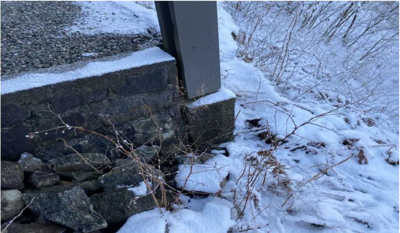
Bilde 17: Viser søylefundament for terrasse.
