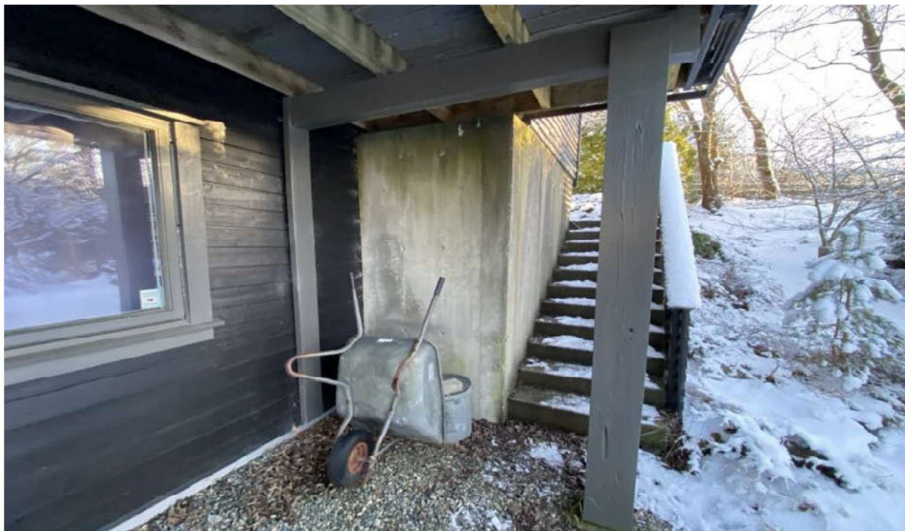
Bilde 13: Viser betongmur /forlengelse av grunnmuren på sørvestre hjørnet, og betongtrapp.
