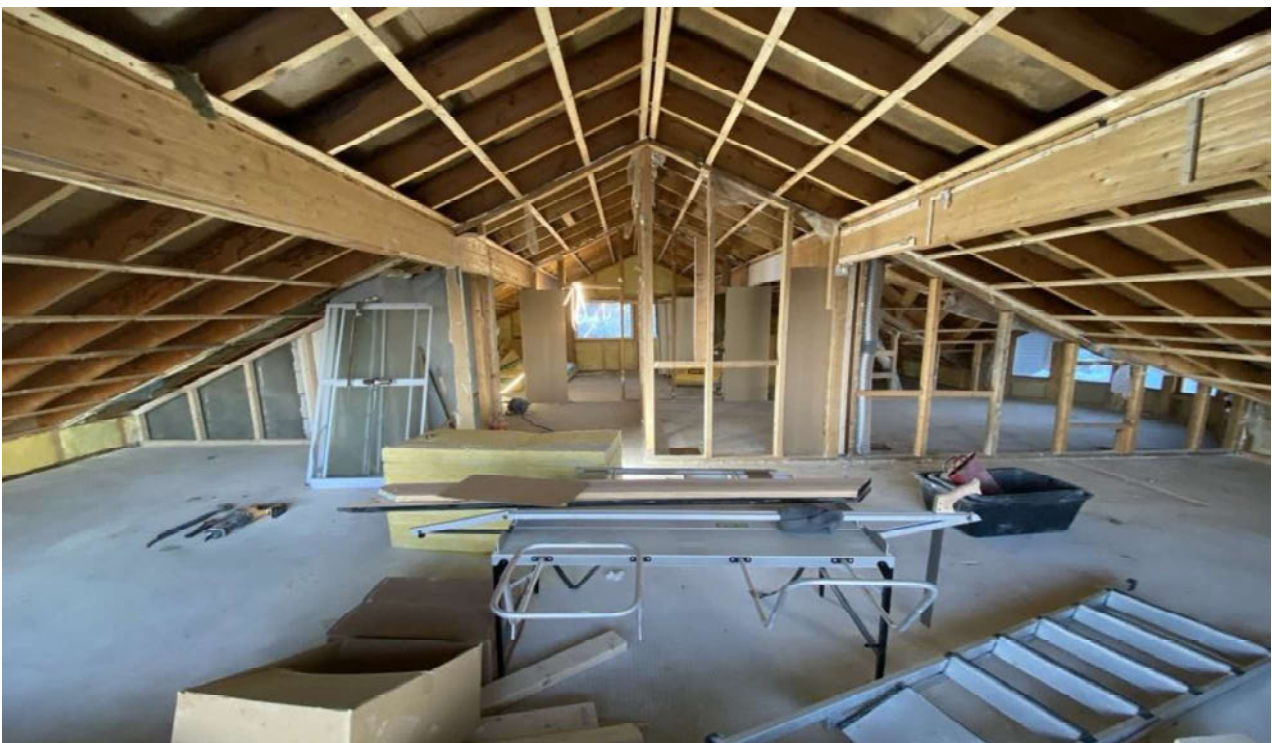
Bilde 2: Viser oversiktsbilde av loftsetasje slik den fremstod ved befaringen.
