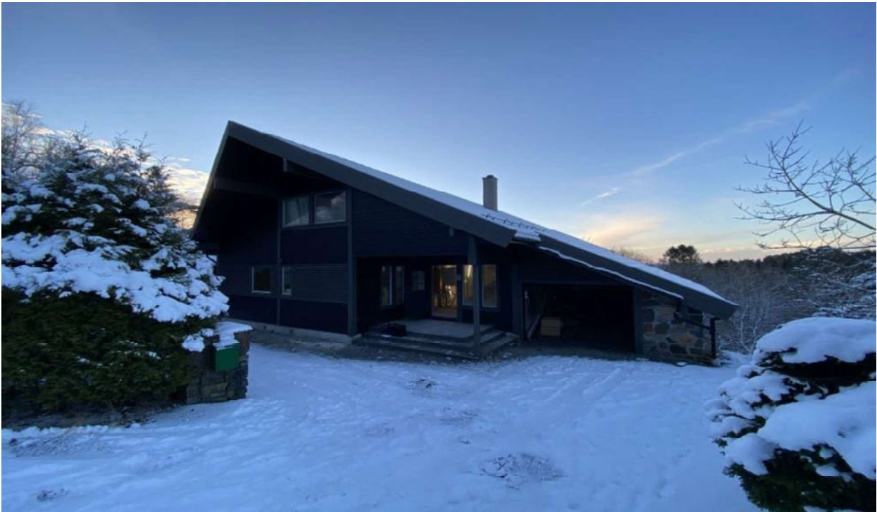
Bilde 33: Viser at yttertaket var snødekket på befaringsdagen.
