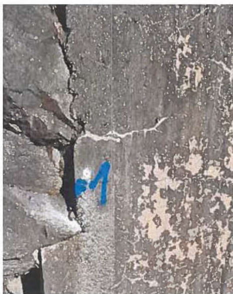
Fastmerke F1 etablert i fast fjell (jfr Vedlegg 4)
