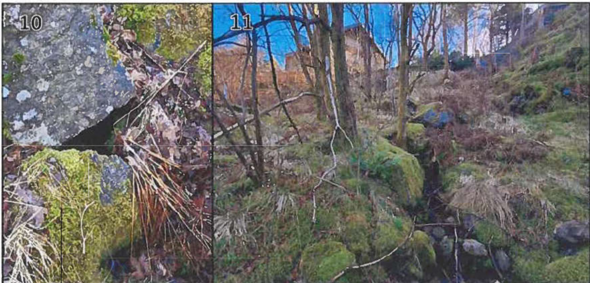
Figur 3-6 Hulrom under dårlige sorterte blokkmasser (10) og utløp av bekken under fyllingen (11).
