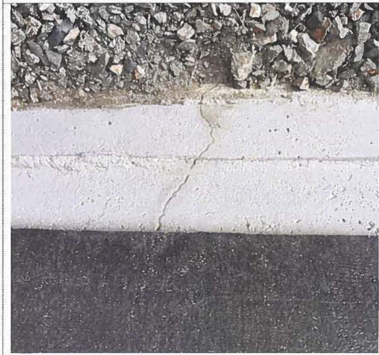
Bilde 3-12: Utbedret sprekk i den lave ringmuren ca. midt på huset i fremkant. I denne delen var alle sprekker injisert/utbedret og overmalt.
