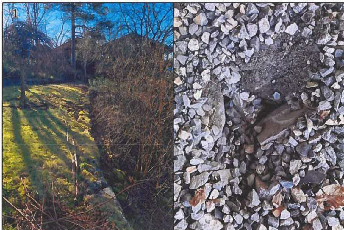
Figur 3-2 (1): Tydelige setninger langs plenen i fyllingstopp. (2): Hulrom inntil kjellerveggen.
