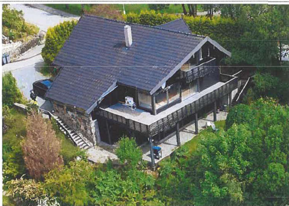
Bilde 3-3: Oversikt enebolig sett i fra sør
