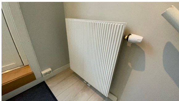
vannbårent varmeanlegg
