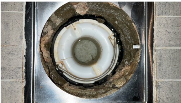
sluk, membran og tettesjikt
