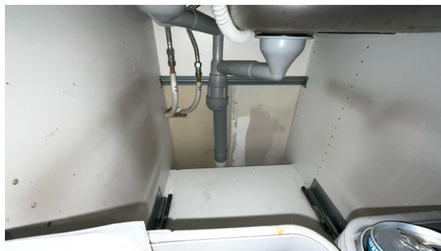
Besiktigelse av rørøpplagg.
