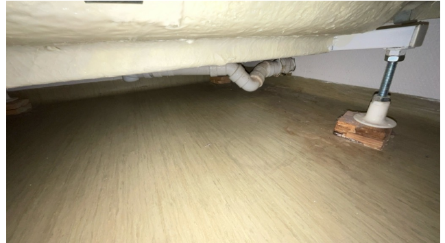
Avløp til dusjkabinett går ut til kjøkkenet.
