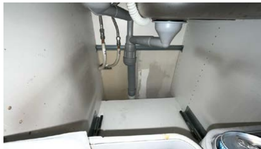
Besiktigelse av rørøpplagg.
