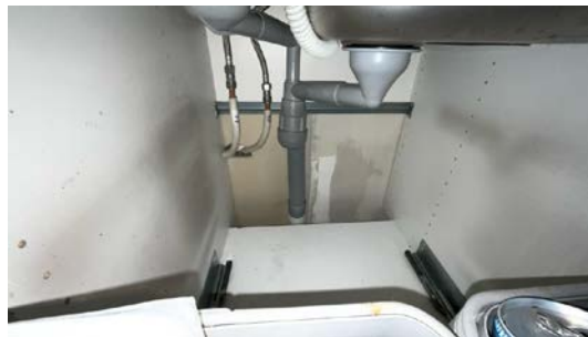
Besiktelse av røropplegg.
