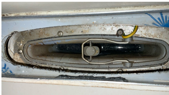
sluk, membran og tettesjikt
