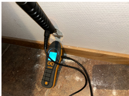
Hulltagning og fuktsøk
