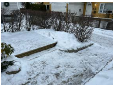
terrasse ved inngang
