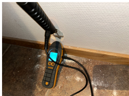
Hulltagning og fuktsøk
