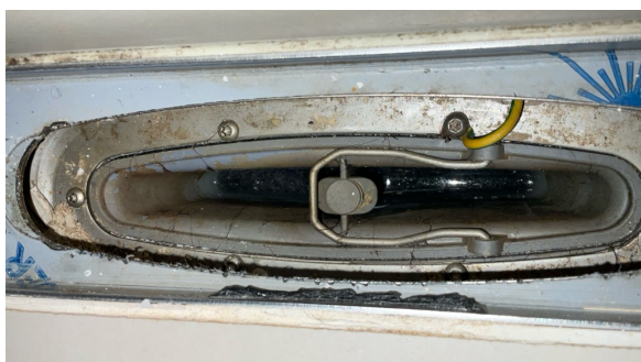
sluk, membran og tettesjikt
