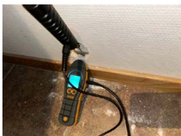
Hulltagning og fuktsøk
