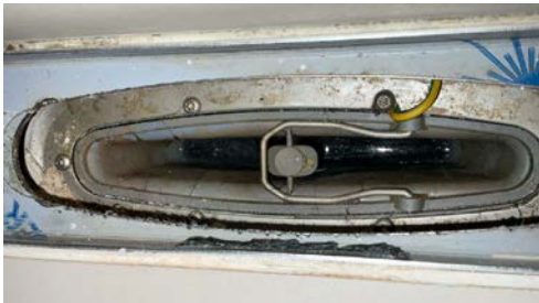
sluk, membran og tettesjikt
