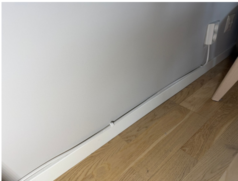
For langt mellom klamringer på ledninger i stue
