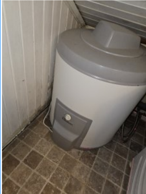
TG 3 7.1.2 Overflate gulv
