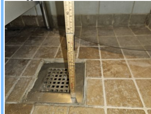
TG 3 7.1.3 Membran, tettesjiktet og sluk
