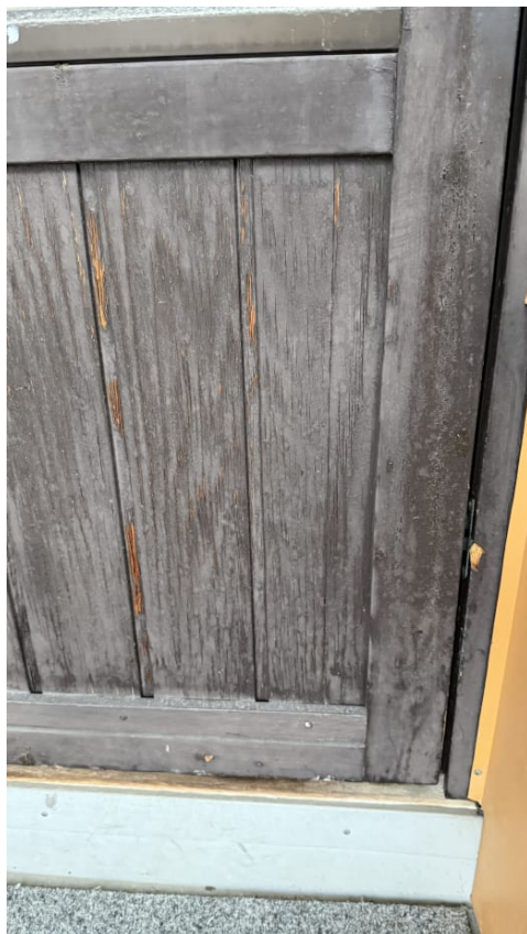
Eksempelbilde av slitasjegrad på terrassedør.
