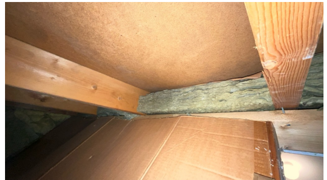
Minimalt med luftespalter på isolert del.
