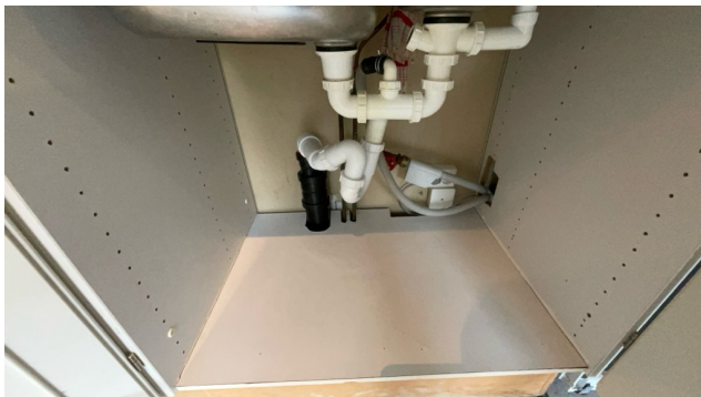
Besiktigelse av røropplegg.
