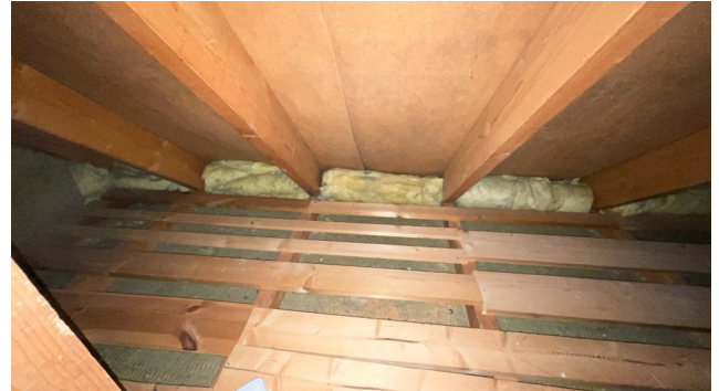
Minimalt med luftespalter på isolert del.
