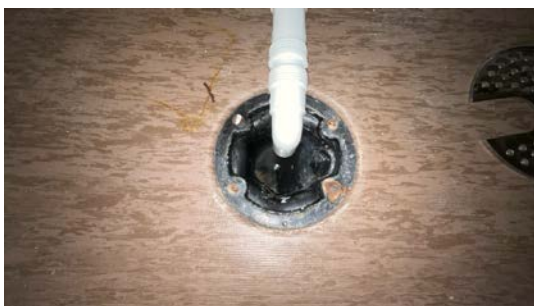
Kontroll av sluk.
