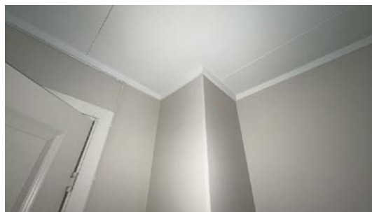
Kontroll rundt pipeløp. Ingen synlige lekkasjer på befaringsdagen.
