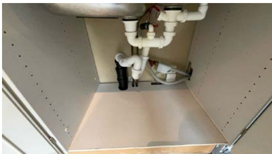
Besiktigelse av rørproplegg.
