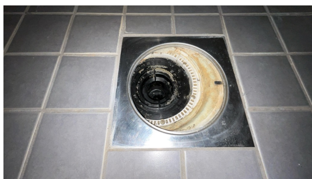
Kontroll av sluk.
