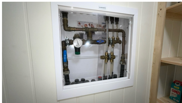
Besiktigelse av røropplegg.
