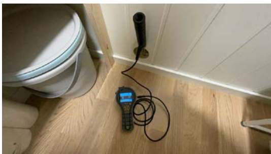
Utført hulltaking på rom under terreng.
