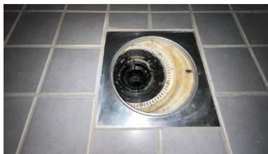
Kontroll av sluk.
