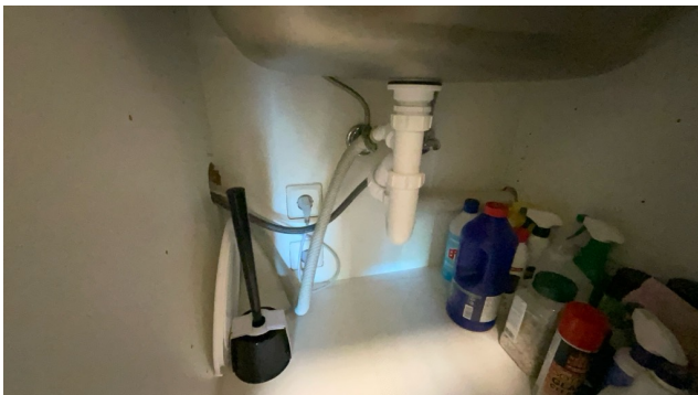
Besiktigelse av røropplegg.
