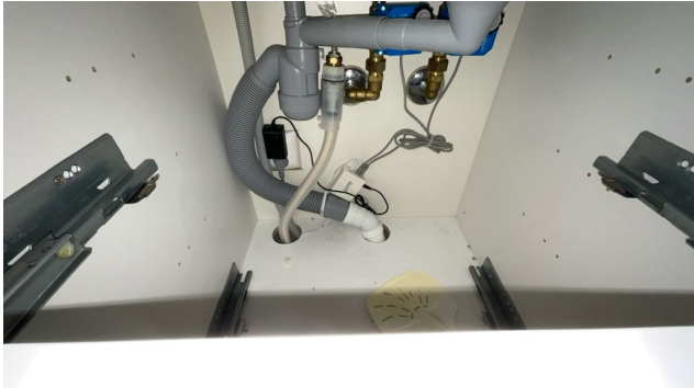
Besiktigelse av røropplegg.
