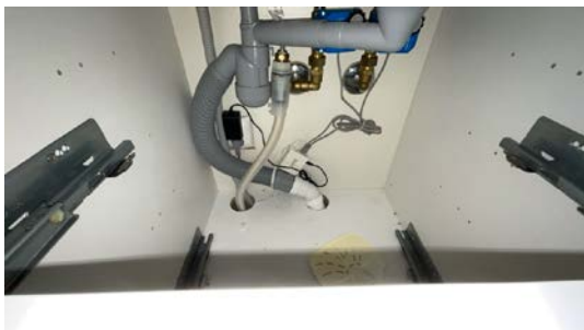
Besiktigelse av rørapplegg.
