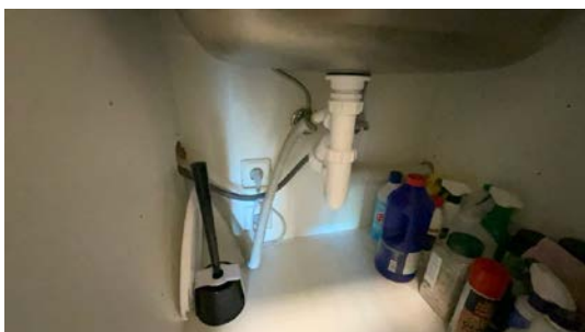
Besiktigelse av rørapplegg.
