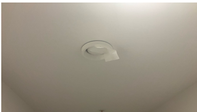
Test av avtrekk i boden.
