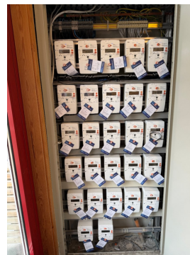
Strømmåler i felles målerskap.
