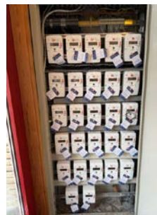
Strømmåler i felles målerskap.
