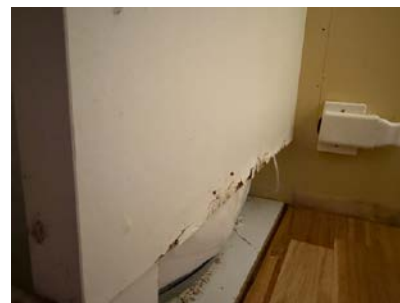
Fuktutsvelling på skapstamme v/ komfyr plass.
