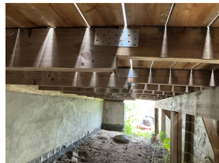
Skjøt er kun festet med beslag og et fåtall skruer.
