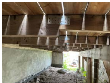
Skjøt er kun festet med beslag og et fåtall skruer.
