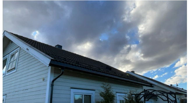
Besiktigelse av taktekke.
