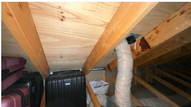
Kontroll rundt rørgjennomføringer.
