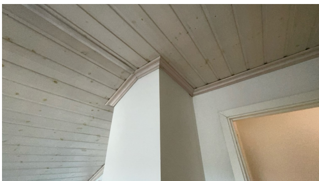
Kontroll rundt pipeløp. Ingen tegn til lekkasjer på befaringdagen.
