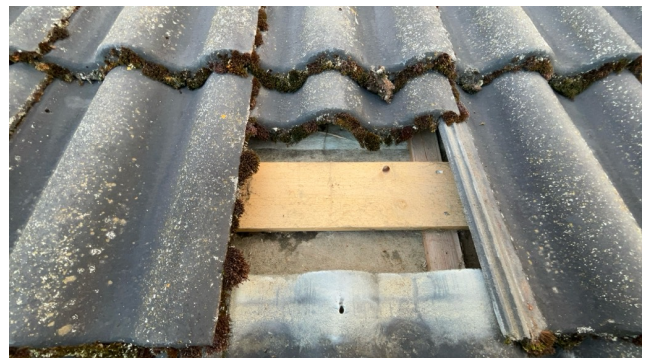
Kontroll av undertak.
