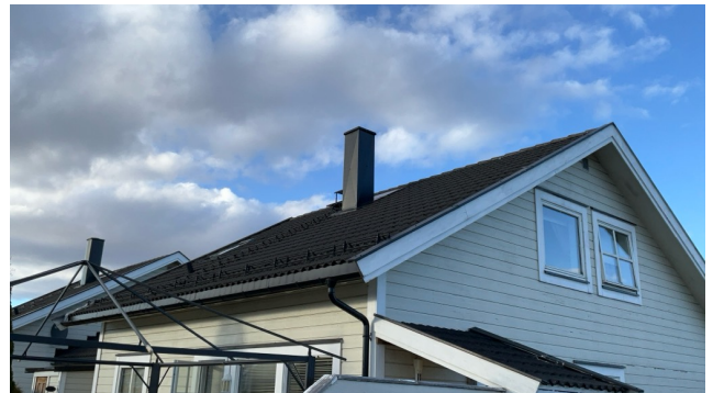
Besiktigelse av taktekke.
