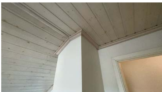
Kontroll rundt pipeløp. Ingen tegn til lekkasjer på befaringsdagen.
