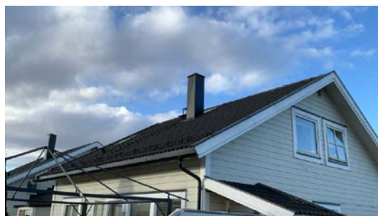
Besiktigelse av taktekke.
