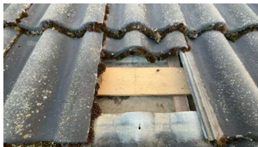
Kontroll av undertak.
