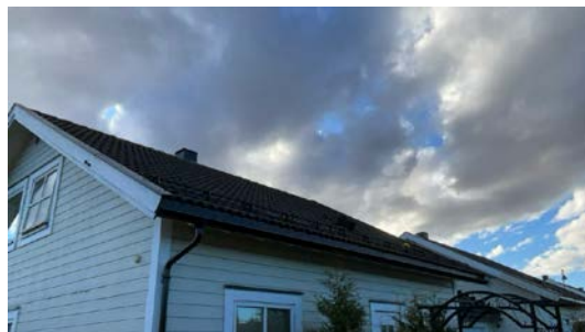
Besiktigelse av taktekke.
