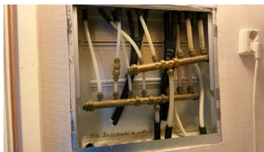
Besiktigelse av røropplegg.
