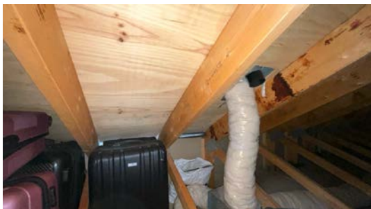
Kontroll rundt rørgjennomføringer.
