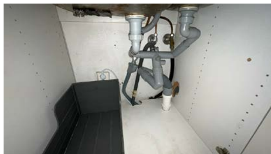
Besiktigelse av røropplegg.
