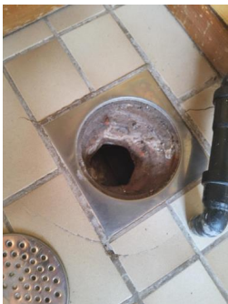
Overflater gulv - Sluk
