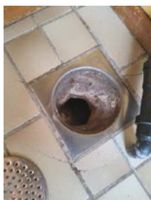
Overflater gulv - Sluk
