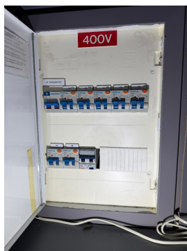
Automatsikringer med skap i stue.
