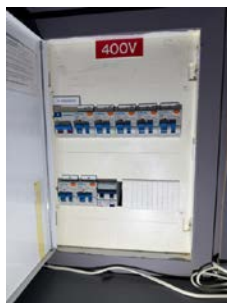
Automatsikringer med skap i stue.
