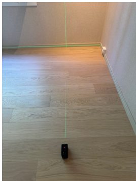
Foto viser nivellering med krysslaser i hovedsoverom
