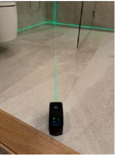
Kontroll med krysslaser av høydeforhold
