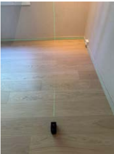
Foto viser nivellering med krysslaser i hovedsoverom
