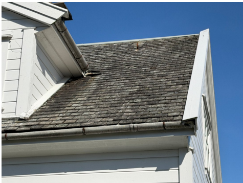
Taktekking sett fra bakkenivå.
