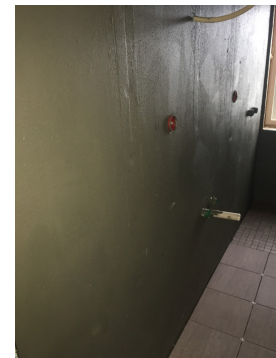
Bilder av membran i forbindelse med modernisering av badet.
