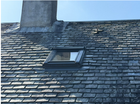
Taktekking sett fra stige.
