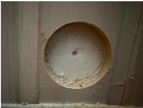
Synlig del av veggkonstruksjon etter hulltaking. Det er montert hvit blindlokk etter hulltaking.
