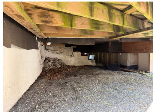
Åpen krypkjeller under tilbygd del.
