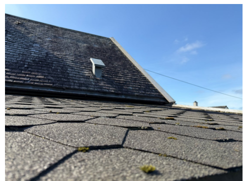
Taktekking sett fra stige.
