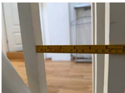
Åpninger i rekkverk er større enn 10 cm. Avvik registrert i HMS punkt.
