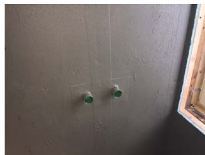
Bilder av membran i forbindelse med modernisering av badet.
