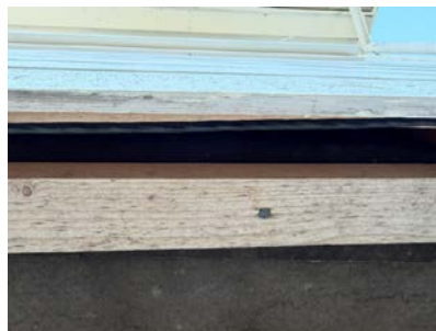
Ingen musebånd bak nederste kledningsbord.
