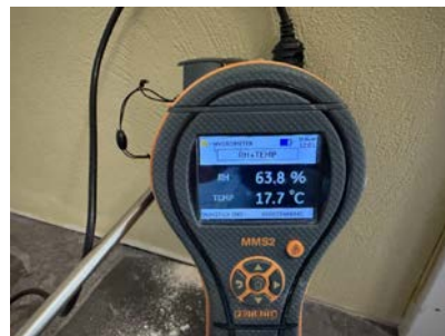
Måling av relativ luftfuktighet.
