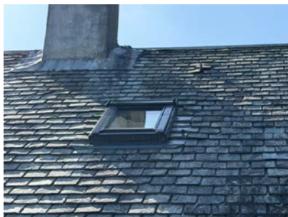
Taktekking sett fra stige.
