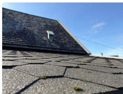
Taktekking sett fra stige.
