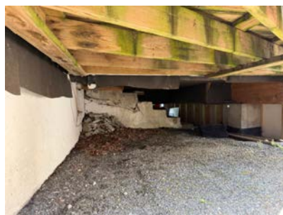
Åpen krypkjeller under tilbygd del.
