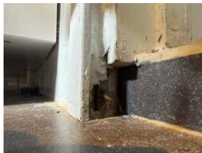
Ingen membranoppbrett v/ døråpning.
