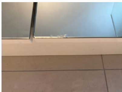
Merke i nedre del av speilskap. Må anses å være normal slitasje.
