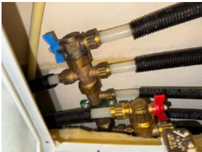
Stoppekraner over himling på badet.
